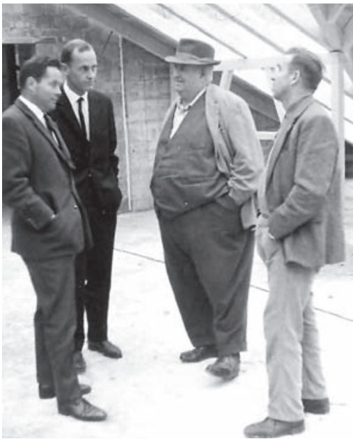
1964: Bau des ersten eigenen Oberstufenschulhauses. Von l. n. r. Heinrich Guggenbühl, Stadel (Reallehrer), Kurt Habegger (Architekt), Johann Jucker, Neerach (OS Schulpräsident), Alfred Maag, Stadel (Gemeindepräsident)
