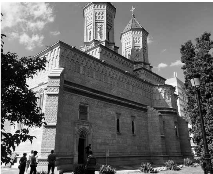
«Drei-Hierarchienkirche» von Iasi rechts ein Detail aus deren Fassade
